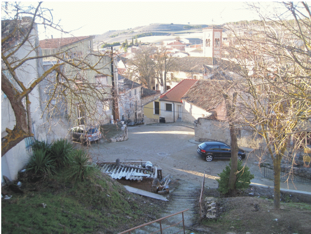
FOTOGRAFÍA 26. Al Este del núcleo, el caserío va ascendiendo hacia el páramo, por un viario angosto en el que se insertan escaleras y taludes para salvar la pendiente. Calle de la Cuesta
