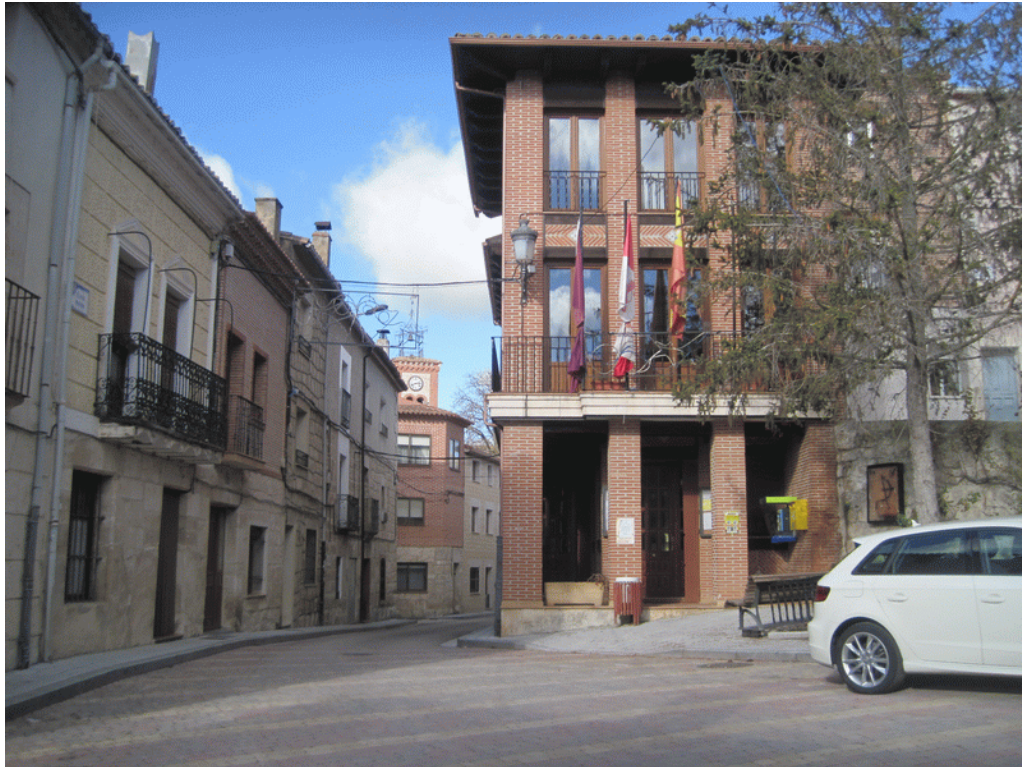
FOTOGRAFÍA 19. Vista de la Calle Mayor y el Ayuntamiento, en el centro de Antigüedad
