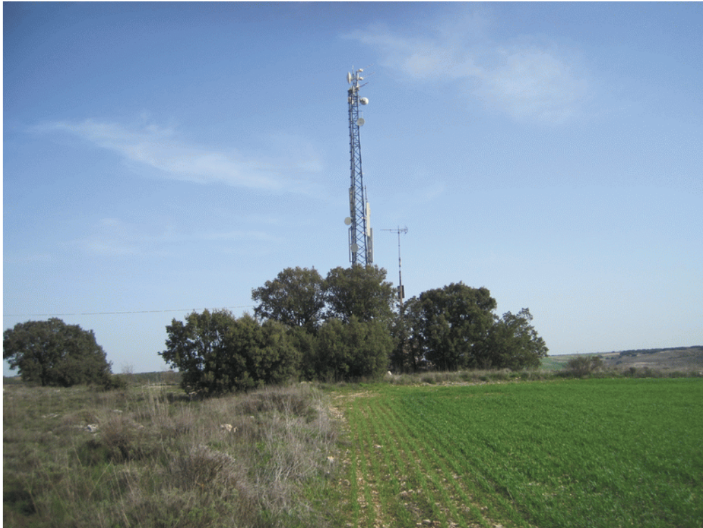
FOTOGRAFÍA 9. Grupo de antenas de telecomunicaciones rodeado de encinas, situado en el borde de páramo, en el cerro de La Atalaya, al Sur de la localidad de Antigüedad
