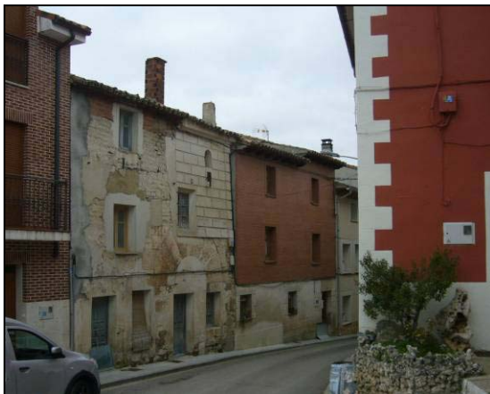
Arco de piedra en vivienda
